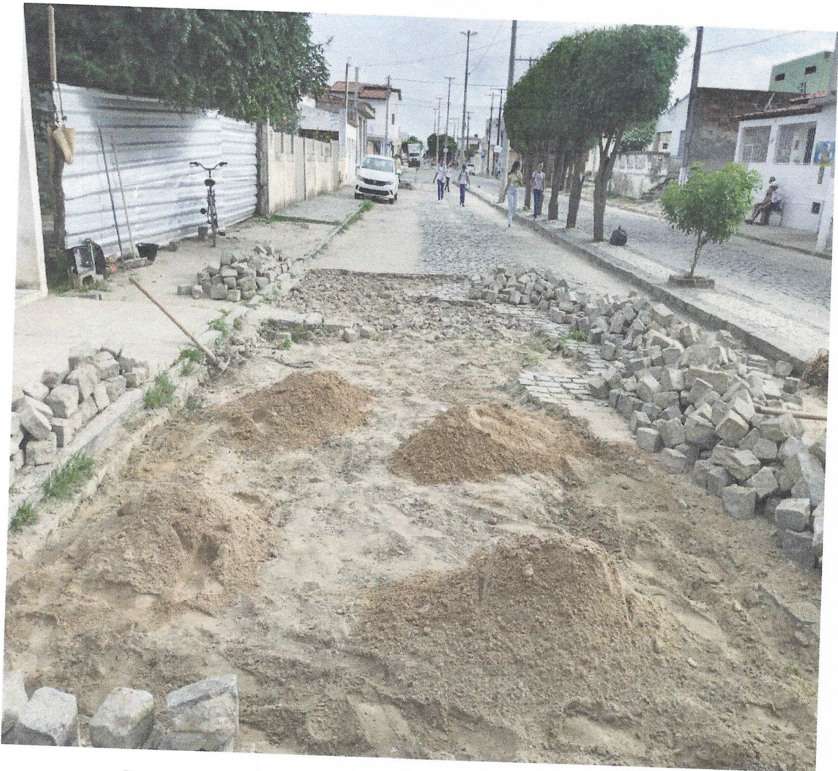
Recuperação de Pavimentação em Paralelo na AV Rosendo Lopes/Sede
